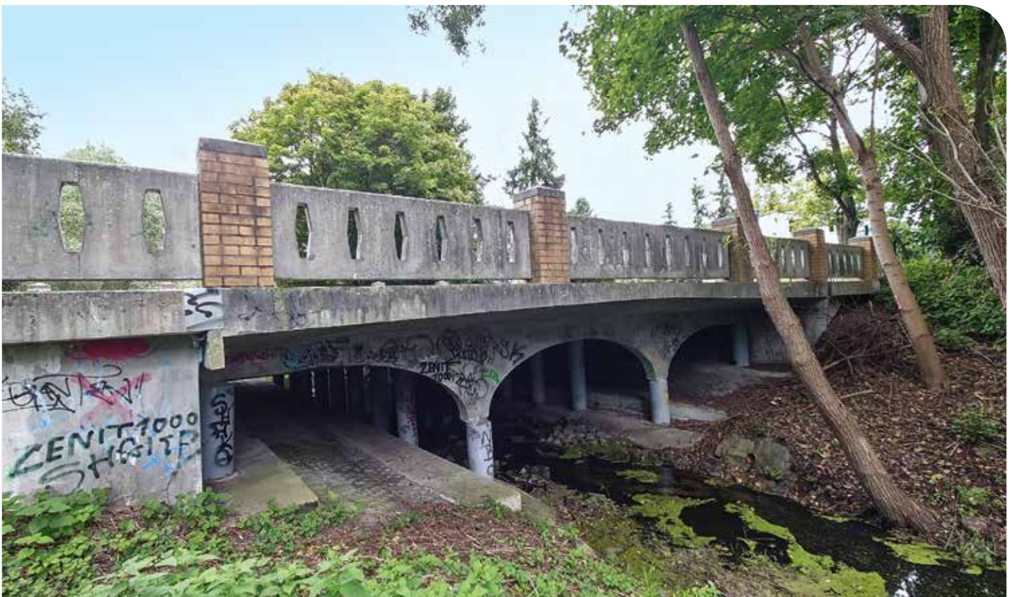
Wird abgerissen: die Kindelfließbrücke auf der Kreisstraße zwischen Glienicke und Schildow
