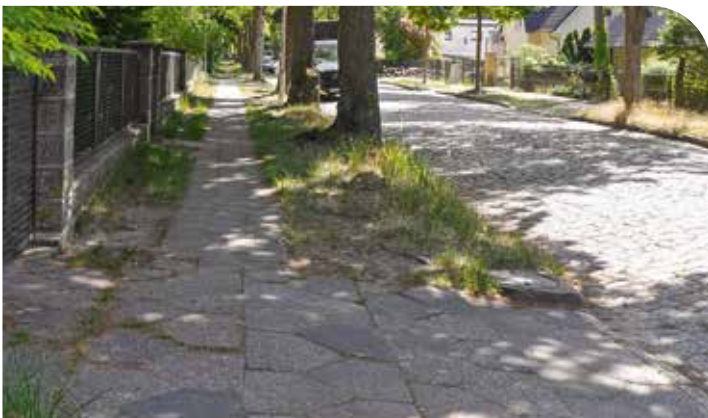
Bekommt einen neuen Gehweg: die Salvador-Allende-Straße
