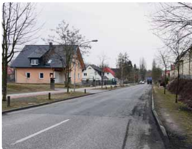
Nach der Schneeschmelze ist es deutlich: Die Fahrbahn der Hattwichstraße weist Winterschäden auf.
