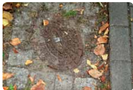
Neben Einläufen der Entwässerungsanlagen sind auch im Boden eingelassene Hydranten von Schnee und Eis zu befreien.
