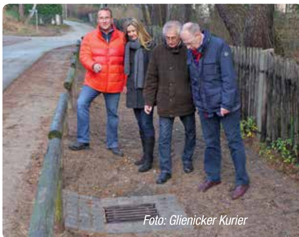
Blick in den Schacht: (v.l.) Ingenieur Christoph Bäske erläutert Kathrin Nickel, Sachbearbeiterin Tiefbau, Peter Staamann, Fachbereichsleiter Bauen und Umwelt, sowie Bürgermeister Hans G. Oberlack das Prinzip der Entwässerung.
