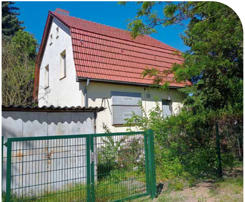
Ist seit zwei Jahren stillgelegt: das Wohnhaus in der Feldstraße 44
