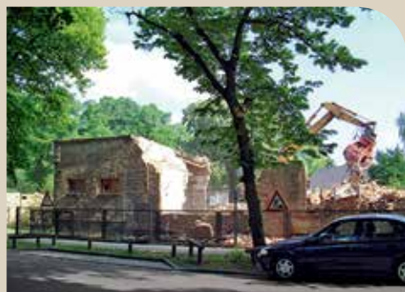
Alte märkische Dorfarchitektur fällt dem Abrissbagger zum Opfer (Mai 2002)
