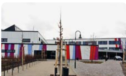
Den Schulneubau gestaltete das Büro Petzi und Thoss.
