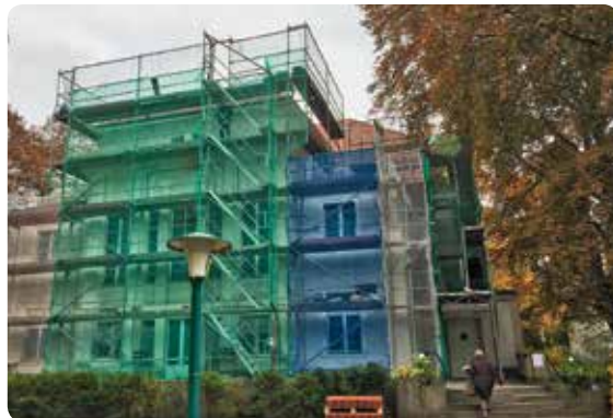
Die Bauarbeiten am Dach des Centre Bagatelle sind im vollen Gange. Foto: Adelheid Gliedner
