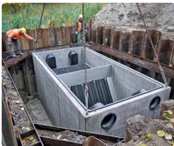
Beim Installieren der Sedimentationsanlage musste präzise gearbeitet werden.
