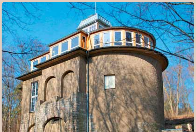
Das im Bau befindliche Lokal.
