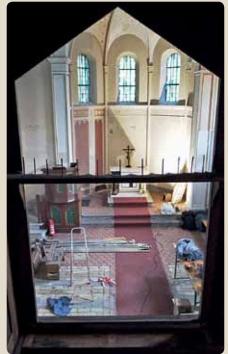
Ein Jahr lang war der Innenraum der Kirche Baustelle. Foto: Archiv/Pelz
