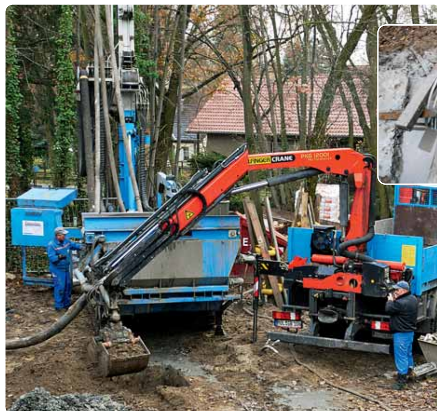
Arbeiter setzen das vierte Bohrloch.
