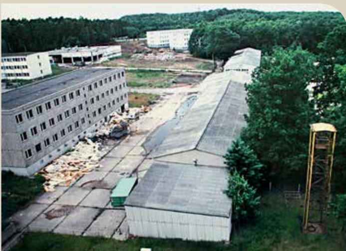
Kaserne „Albert Hößler“ – Stasiobjekt an Glienicke Ortsrand kurz vor dem Abriss.
