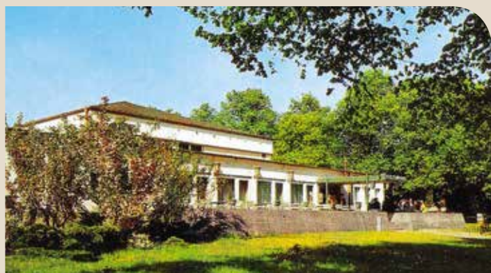
Bild 3: Das neu errichtete Kulturhaus „Olga Benario-Prestes“
