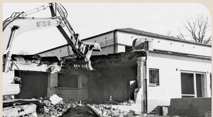
Bild 4: Abriss des Kulturhauses im März 2001
