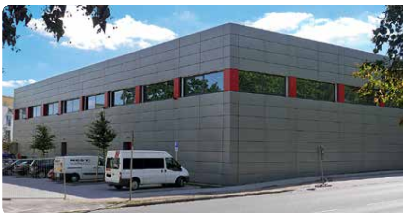
Nun fertig: Die neue Sporthalle komplettiert das NGG
