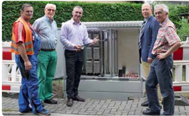
Ließen sich die neue Technik in der Charlottenstraße erklären: Bürgermeister Dr. Hans G. Oberlack (2.v.r.), Peter Staamann, Fachbereichsleiter für Bauen und Umwelt (rechts), sowie Gemeindevorsteher Martin Beyer (2.v.l.) lauschten den Ausführungen von Telekom-Mitarbeiter Henry Lange (Mitte) und Ulrich Griga von der bauausführenden Firma.
