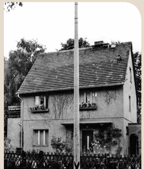
Im Sperrgebiet: In dem Haus mit der Nummer 46 im Sandkrug lebte die Familie Andrae. Das Foto stammt aus dem Jahre 1969. Im Vordergrund ist ein Zehn-Meter-Betonmast zu erkennen, dessen Leuchte das Grenzgebiet nachts erhellte.
