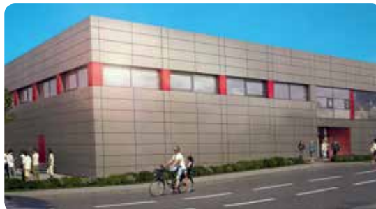
So soll sie aussehen: die Sporthalle am Neuen Gymnasium in Glienicke/Nordbahn
