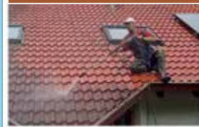
Dach- / Dachrinnen- reinigung
