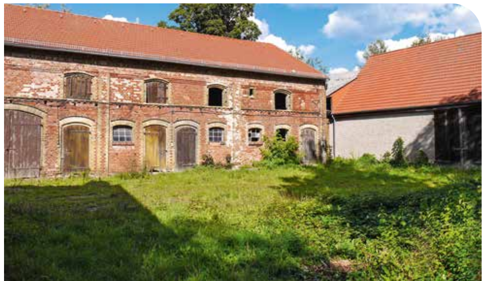
Die Stallungen (links) und die Scheune sind Teil eines Ensembles, das erhalten werden muss.
