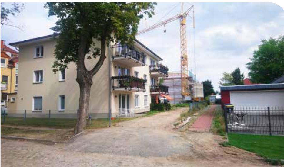
In Schildow entsteht kommunaler Wohnungsbau
