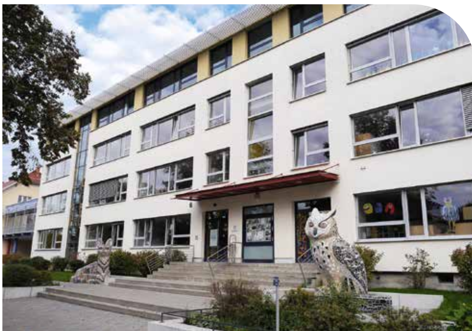
Wird nach Ansicht der Befürworter eines Schülerweiterungsbaus den heutigen Lernformen und Sicherheitsanforderungen nicht mehr gerecht: die Grundschule
