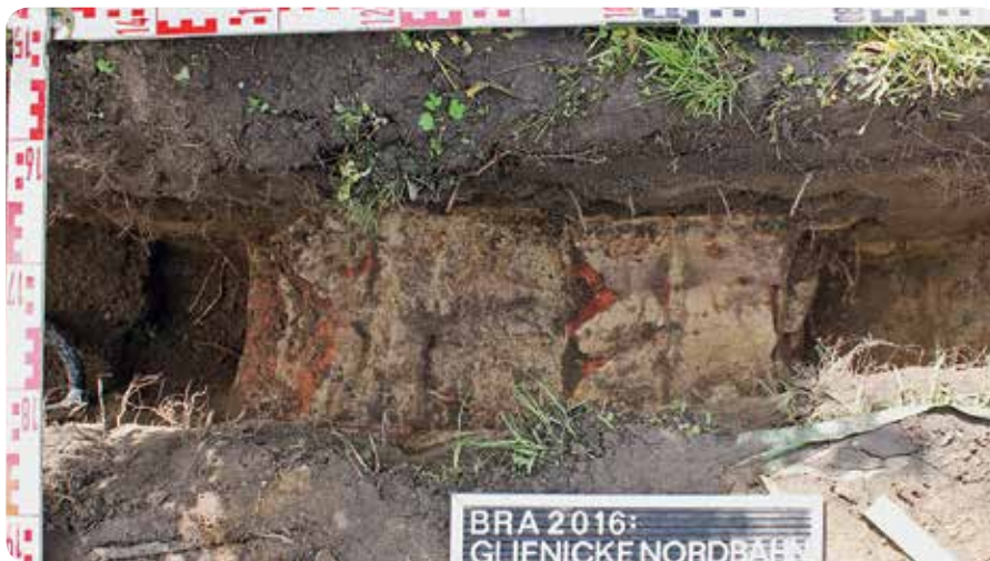
Fundament vor dem Portal
