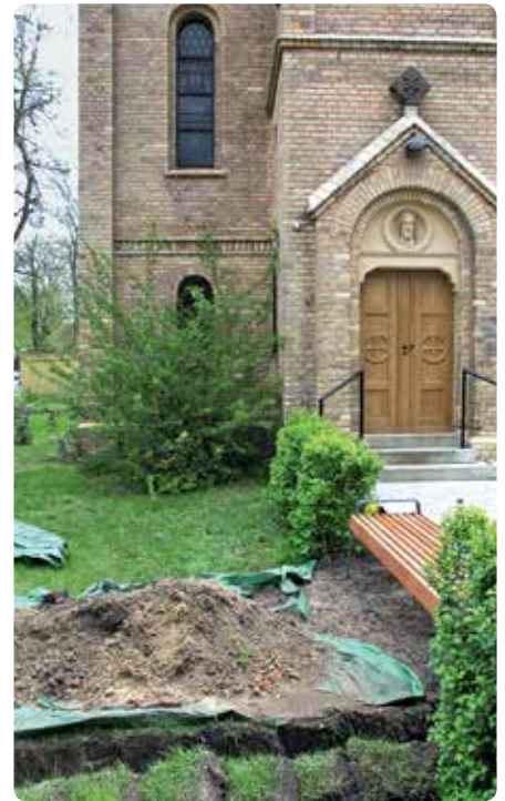
Kabelgraben vor dem Portal
