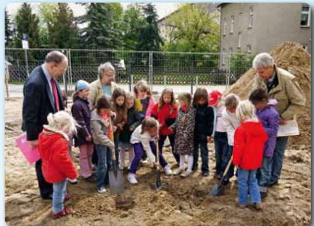
Kinder des Hort-Chores setzen den ersten Spatenstich für den Neubau.
