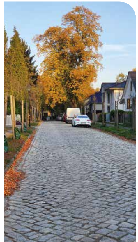
Die Leipziger Straße: eine Haupteerschließungsstraße mit Großkopfsteinpflaster ohne Radweg und mit teils sanierungsbedürftigem Gehweg... Foto: Susanne Kübler
