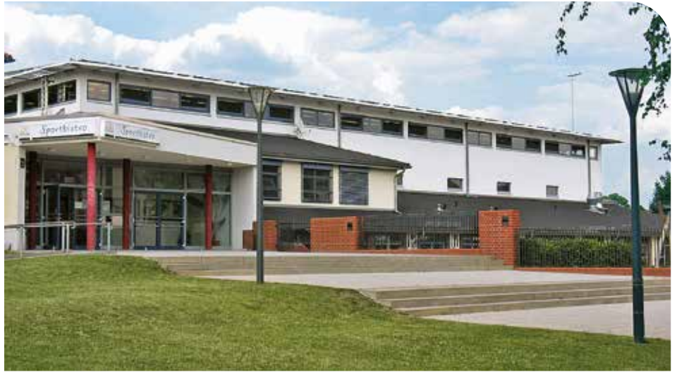
Derzeit nicht voll nutzbar: Teile der Dreifeldhalle sind wegen Bauarbeiten mindestens bis November gesperrt.
