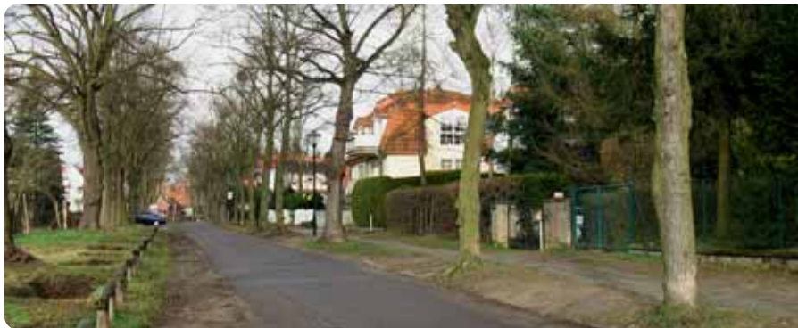
Welche Straßen und Gehwege in welcher Reihenfolge erneuert oder ausgebaut werden, wird durch Prioritätenlisten festgelegt. Foto: Archiv
