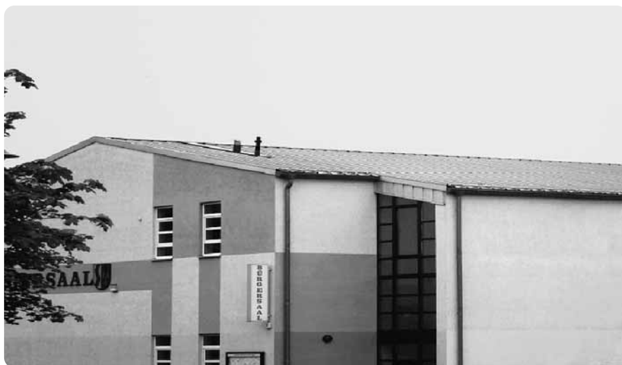
Auf dem Dach des Schildower Bürgersaals soll die Solaranlage installiert werden. Foto: privat
