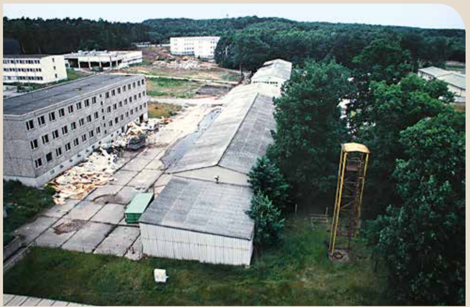
Unfreiwillig zu Gast: In der ehemaligen Kaserne der Grenztruppen und später des Ministeriums für Staatssicherheit wurde Viola Fitzkow 1961 verhört. Das Foto zeigt das Objekt kurz vor dem Abriss 1995. Am heutigen Ort befindet sich das Wohngebiet Schönfließ-Bieselheide. Foto: Baugesellschaft DEMOS
