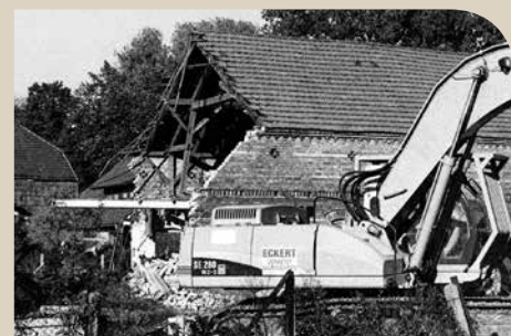
Abriss des Bauernhofs Hauptstraße 10 im Oktober 1995
