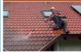
Dach- / Dachrinnen- reinigung
