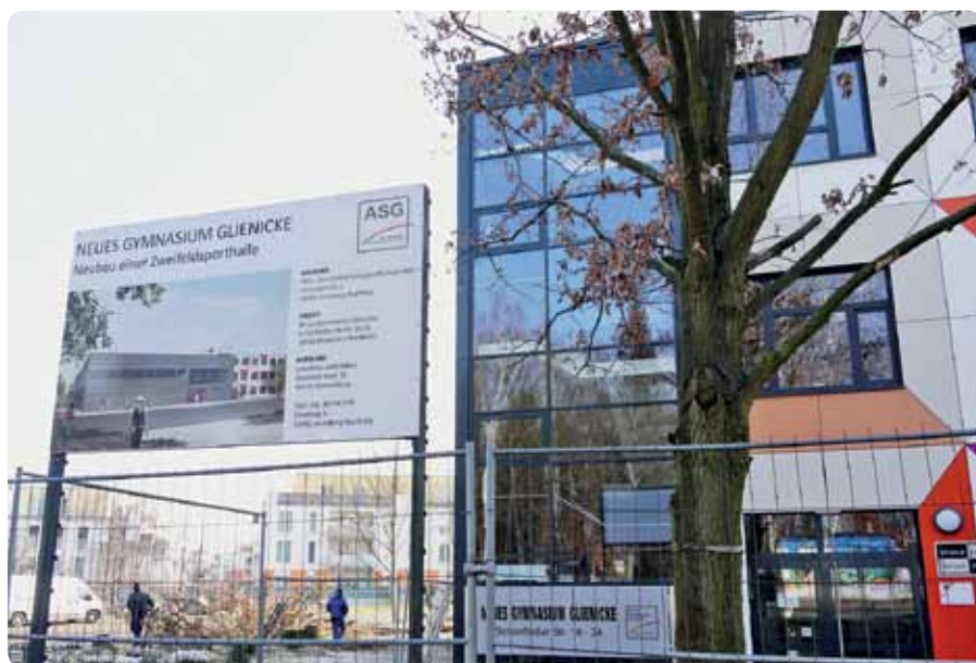
Das Bauschild steht bereits: Am NGG soll eine Zweifeldhalle entstehen.
