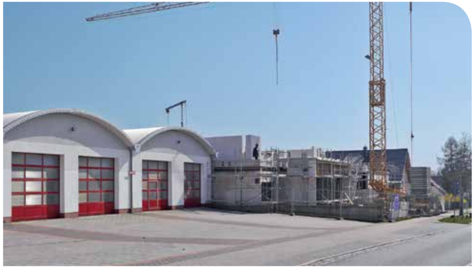
Die Erweiterung der Feuerwache macht Fortschritte: Die Infrastruktur für unsere Freiwillige Feuerwehr stimmt!
