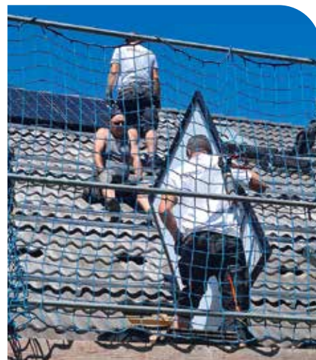
Installation einer Photovoltaikanlage
