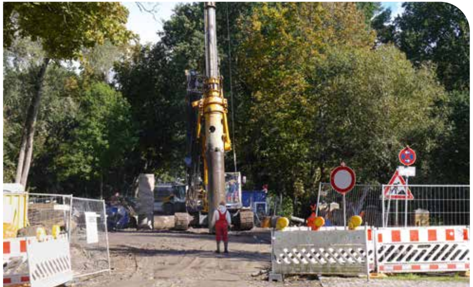
Baumaßnahmen in Glienicke: Arbeiten an der Kindelfließbrücke, bald auch auf der Kreisstraße.
