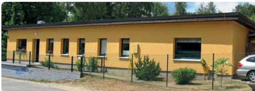
Dach, Fenster, Fassade und Außenanlage ist bereits neu: Nun wird innen saniert. Foto: Archiv
