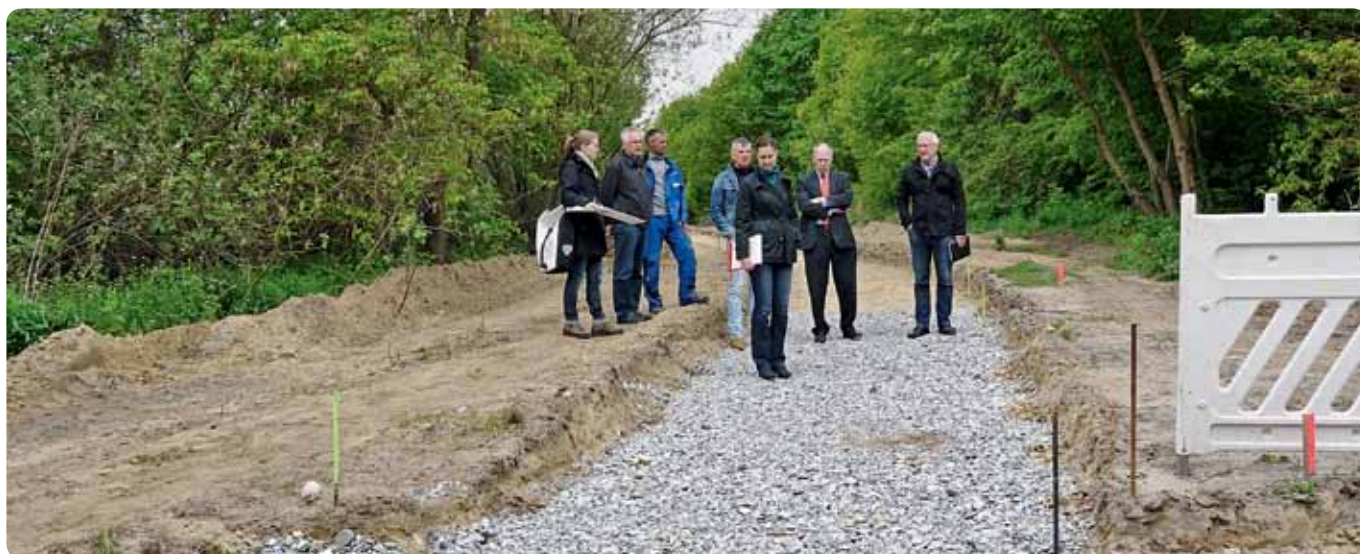
Vertreter von Verwaltung, Baufirma und Architekten besichtigten gemeinsam die Baustelle für eine weitere Strecke des Wanderweges an den Eichwerder Moorwiesen.
