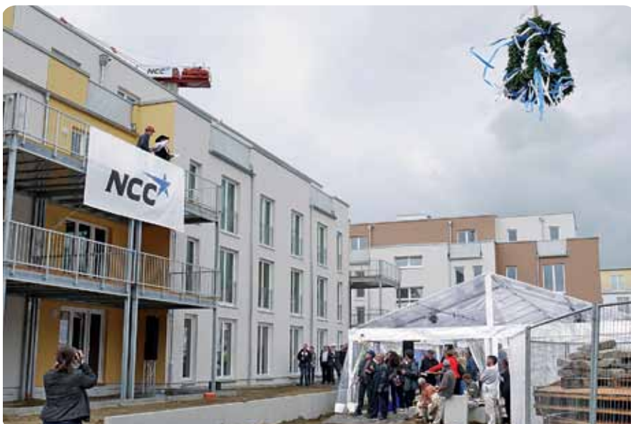
Die Richtkrone drehte sich über der Baustelle.
