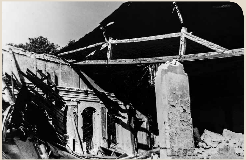
Nach dem Einsturz des Daches nur noch eine Ruine: Der ehemalige Gasthof Sandkrug 1964.
