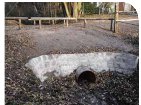
Neues Rohr für den Durchlass an der Sophienstraße
