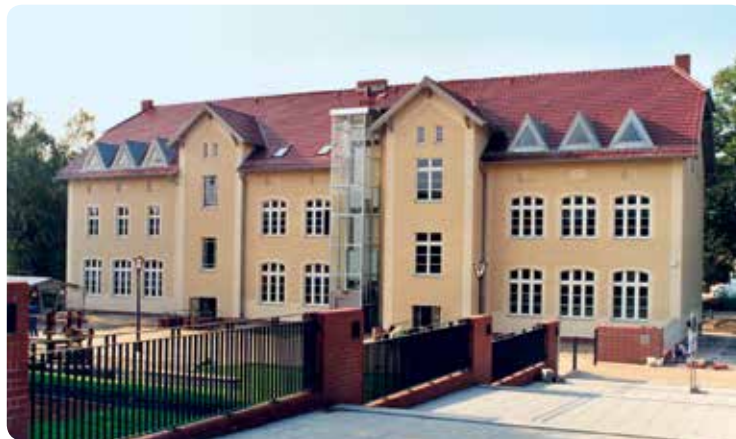
Wird Bestandteil des Konzeptes zur Wärmeversorgung: Der Grundschul-Altbau
