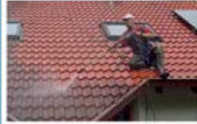
Dach- / Dachrinnen- reinigung
