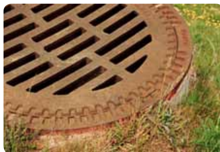
In Sachen Abwasser wollen die S-Bahn-Gemeinden künftig gemeinsame Wege gehen.
