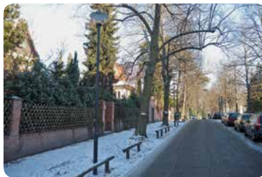
Nachher: die neuen energiesparenden Elektroleuchten
