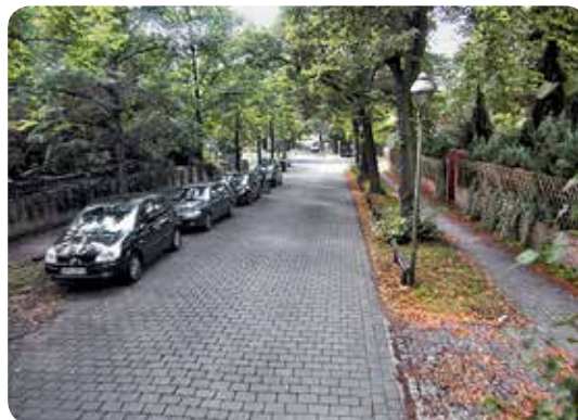
Vorher: die alten Gasleuchten in der Leipziger Straße
