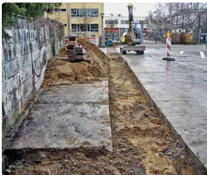
Bauarbeiten am Grundschulgelände
