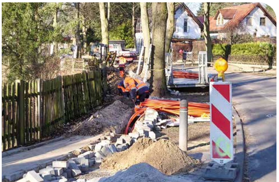
In Glienicke-West wird derzeit gebuddelt: Der Breitbandausbau in der Gemeinde kommt voran.
