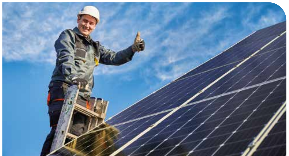
Daumen hoch für die Eigenstrom-Produktion
