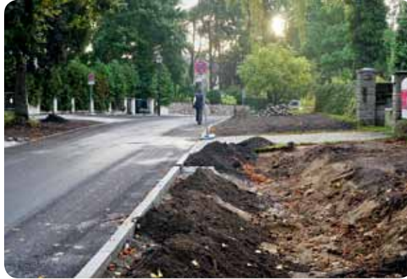
Die Karl-Marx-Straße wird derzeit ausgebaut.
