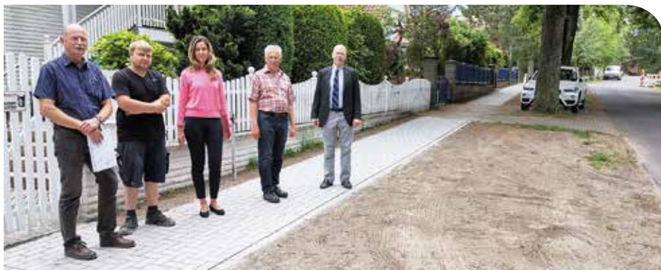
Begutachteten den neuen Gehweg in der Tschaikowskistraße: (v.l.) Planer Rainer Frommeyer, Stefan Hörster von der Baufirma Gutsch, Kathrin Nickel, stellvertretende Bauamtsleiterin, Bauamtsleiter Peter Staamann und Bürgermeister Dr. Hans G. Oberlack
