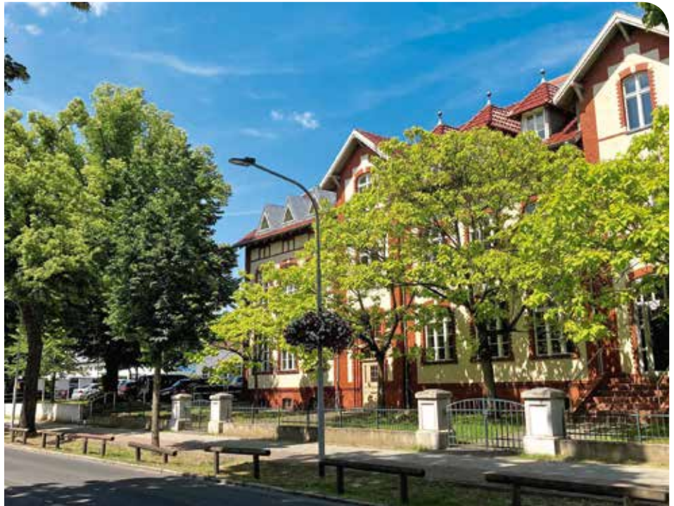
Die neuen Leuchten auf der Hauptstraße.
