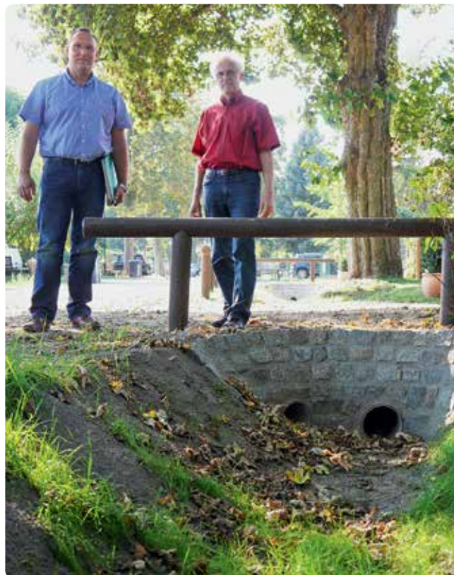
Inspezierten das neue Muldensystem in der Breitscheidstraße: Christoph Bäske von der Bauüberwachung (links) und Bauamtsleiter Peter Staamann
