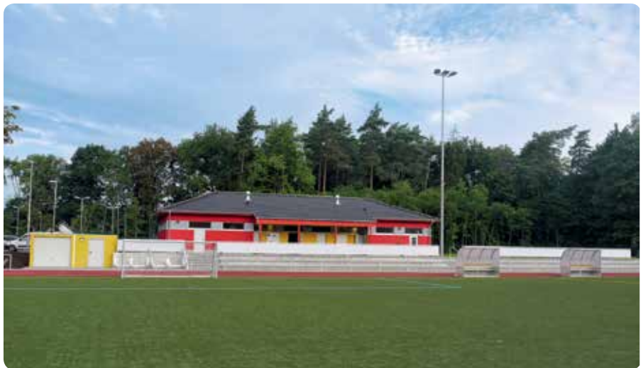
Wird erweitert: Das Funktionalgebäude auf dem Sportplatz Bieselheide erhält auf der Rückseite einen Anbau.
