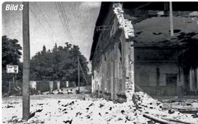
Bild 3 Im Jahre 1964 wird die historische Gaststätte „Sandkrug“ abgerissen. Quelle: Ortschronik, privat
