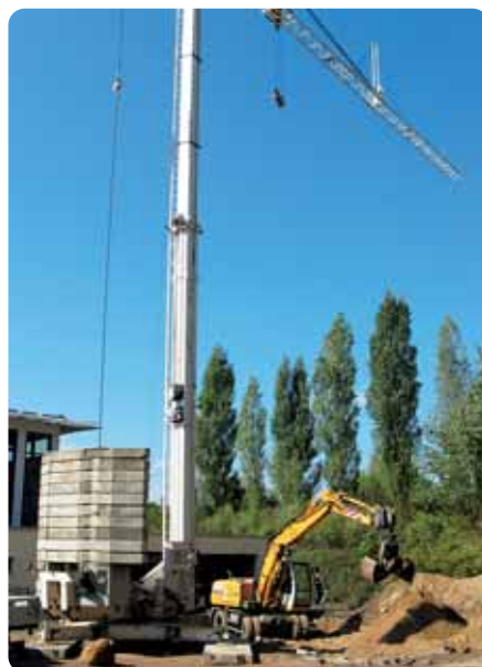
Der Umbau von Schießanlage und Kegelbahn ist inzwischen in vollem Gange, wird aber mehr kosten als ursprünglich veranschlagt war.
