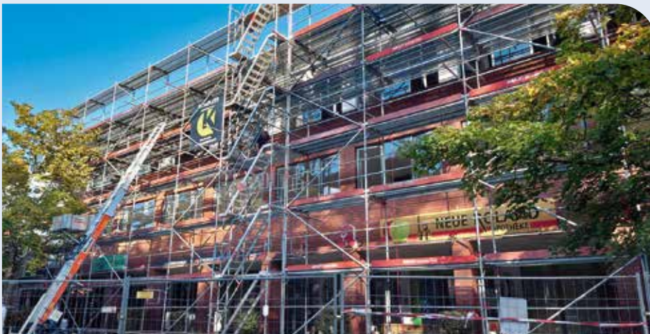
Im Vorfeld der Sanierungsarbeiten: Das Wohn- und Geschäftshaus ist eingerüstet.
