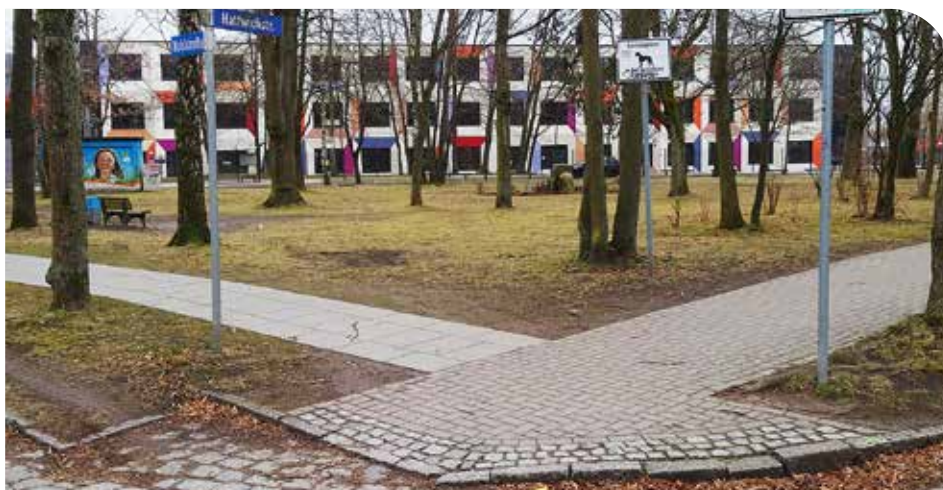
Noch sind die Straßenquerungen in der Nohlstraße nicht barrierefrei.
