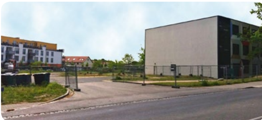
Hier soll die neue Sporthalle für Glienicke entstehen.
