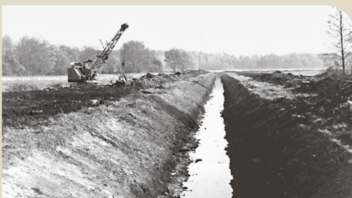
Bild 2: Meliorationsarbeiten im Kindelseegebiet, 1967
