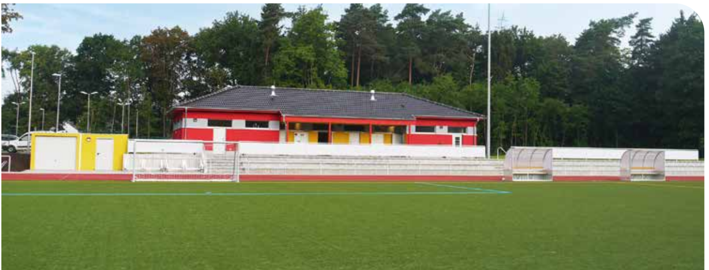
Kunstrasenplatz in der Bieselheide: Die Suche nach einem Gutachter gestaltete sich für die Verwaltung erfolglos.
