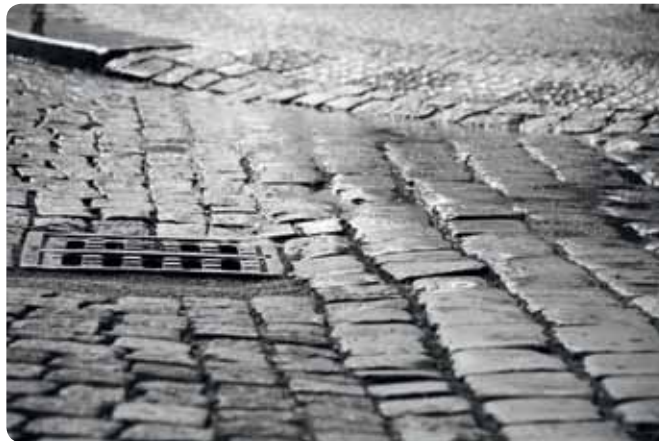
Nicht allorts in Glienicke fließt das Regenwasser bei starkem Niederschlag gut ab. Die Verwaltung hat Problembereiche benannt und Lösungsansätze vorgestellt. Foto: Marvin Siefke/pixelio.de
