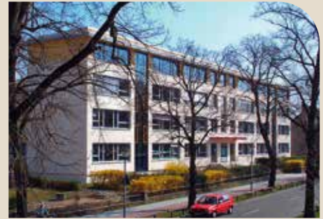
Bild 2: Das neue Schulgebäude (Ansicht bis 2003)
