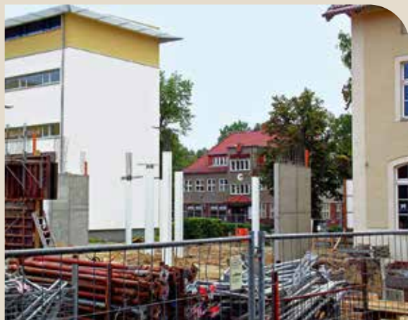
Bild 5: Bauarbeiten zwischen den Schulgebäuden im September 2003
