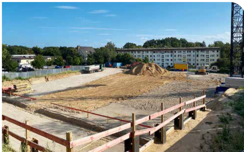
Hier entstehen fünf Etagen Beton, die unseren Ortskern nachhaltig, nicht zum Positiven, verändern werden. Foto: privat
