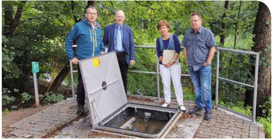
Überzeugten sich von der neuen Technik: (v.l.) Uwe Peters, Projektleiter von Voigt Ingenieuren, Bürgermeister Dr. Hans G. Oberlack, Gabriele Rönsch vom Regiebetrieb Schmutzwasser der Verwaltung und Peter Pester, Oberbauleiter von Voigt Ingenieuren
