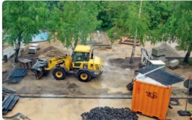
Mitte Juni war der Schulhof noch eine Baustelle – heute darf schon nach Herzenslust gespielt werden.
