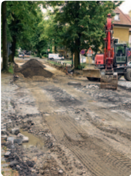
Ende Juni war die Baustelle noch in vollem Gange...
