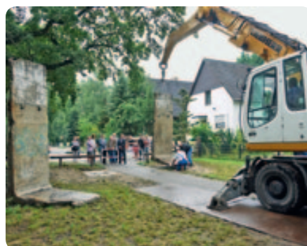
Für das Aufstellen der Mauersegmente war schwere Technik nötig.
