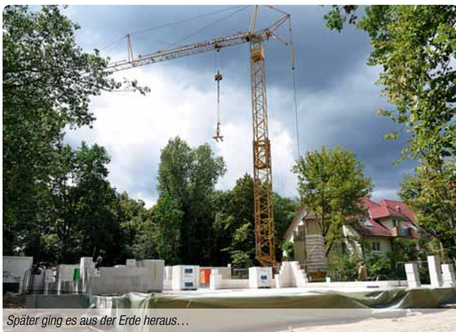
Im Juni waren schon die Kellerräume zu erkennen.
